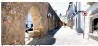
Aqueducte da Agua da Prata
