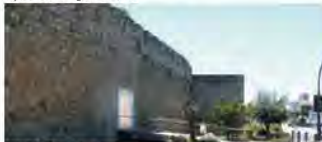
Muralla Canta Velha
